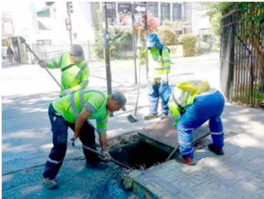
Se ha trabajado en la limpieza de sumideros para evitar inundaciones.
