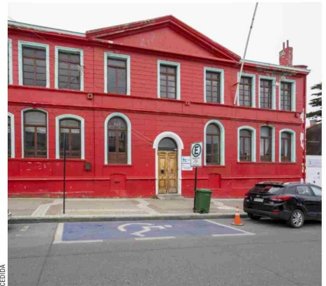
El edificio de Balmaceda 736, el primero que Hogar de Cristo adquirió en la región en 1985.
