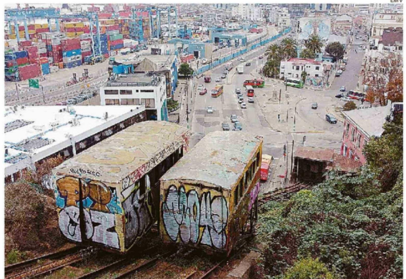
LA INICIATIVA CONTEMPLA ASCENSORES OPERATIVOS Y FUERA DE SERVICIO, CON FOCO EN RECUPERACIÓN.
