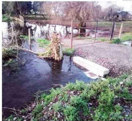
EN TACAMÓ LOS PATIOS ESTÁN INUNDADOS POR MALA EJECUCIÓN DE OBRAS.
