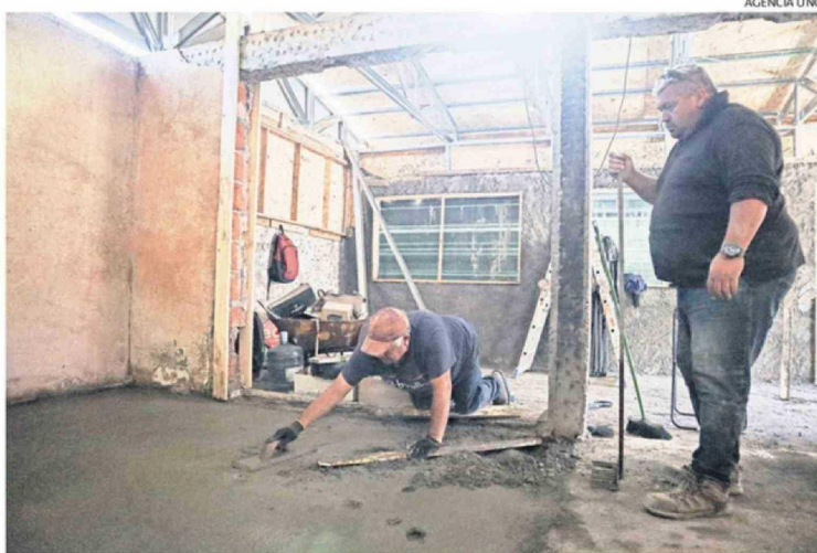
VECINOS SE ENCUENTRAN TRABAJANDO EN LA REPARACIÓN Y CONSTRUCCIÓN DE SUS VIVIENDAS.
