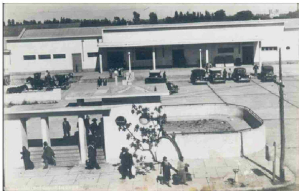
Estación Ferroviaria de Linares, vista desde Independencia
