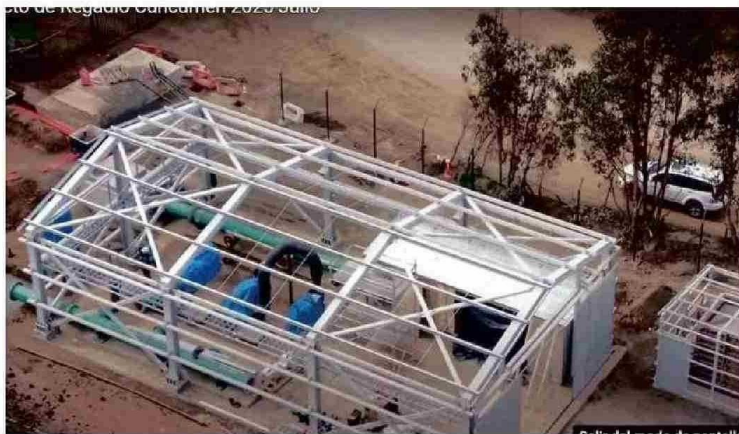
EL MOP ESTÁ EN LA TERCERA ETAPA DE CONSTRUCCIÓN.
