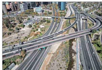
El proyecto contempla reemplazar las cuatro vigas metálicas originales por ocho nuevas de alta resistencia.
