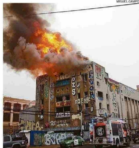
EL EDIFICIO ESTABA TOMADO Y TOTALMENTE VANDALIZADO.
