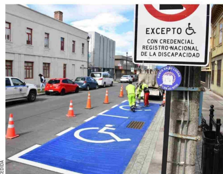
Estacionamientos para personas con discapacidad en Punta Arenas.
