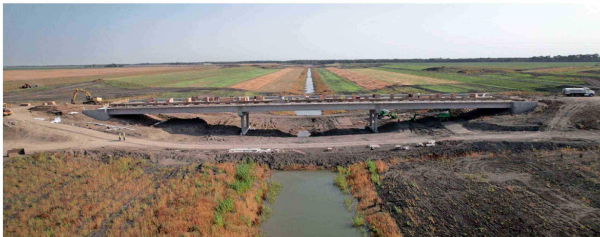
Hasta ahora, se ha excavado el equivalente a más de 10.000 piscinas olímpicas.
