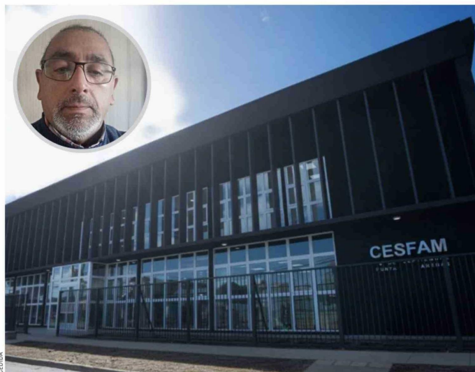
El edificio se convertirá en el Cesfam más importante de la capital regional.
