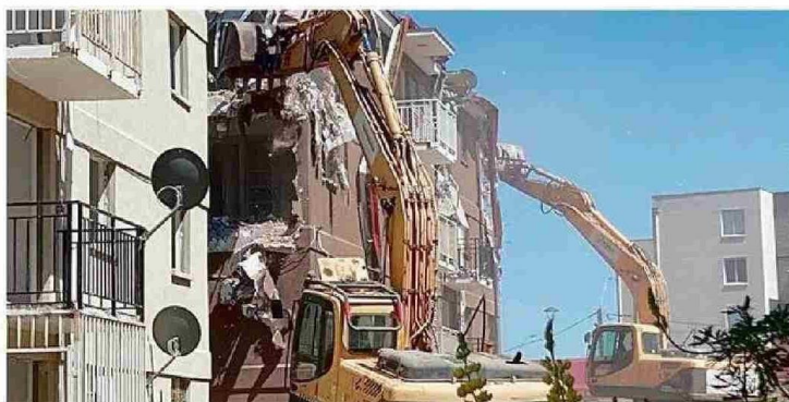
A MEDIADOS DE DICIEMBRE DEL AÑO PASADO SE INICIÓ LA DEMOLICIÓN DE LOS DEPARTAMENTOS.
