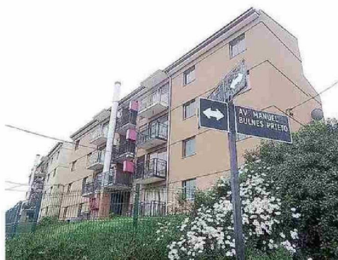
LOS DEPARTAMENTOS FUERON DERRIBADOS POR GRAVES FALLAS.
