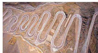
OBSTÁCULO. Los caracoles fueron uno de los puntos críticos de la travesía, debido a la altura y el desnivel.
