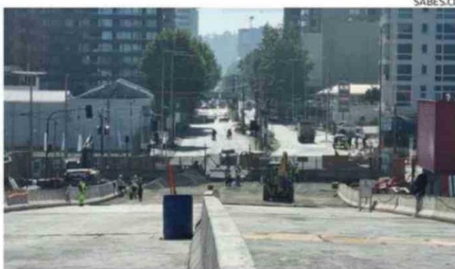
El viaducto ya está conectado a avenida Chacabuco.
