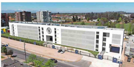
La Universidad Católica del Maule cuenta con dos edificios certificados bajo el sistema CES (Certificación Edificio Sustentable).
