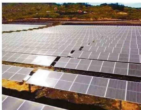
EL PARQUE FOTOVOLTAICO CONTEMPLABA CAPACIDAD DE 2,29MW.
