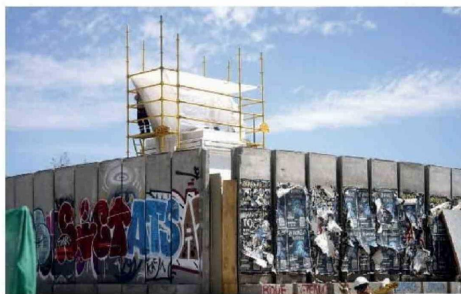
► Este viernes comenzaron los trabajos en el monumento.
