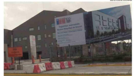
VISTA DE LA OBRA EN LA COMUNA DE ANCUD.
