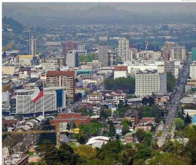
UN GRAVE PROBLEMA AFECTA A CIENTOS DE VECINOS DE CONDOMINIOS SOCIALES DE TEMUCO, QUE ESPERABAN SER FAVORECIDOS POR UN IMPORTANTE PROYECTO QUE HOY ESTÁ "TRABADO".
