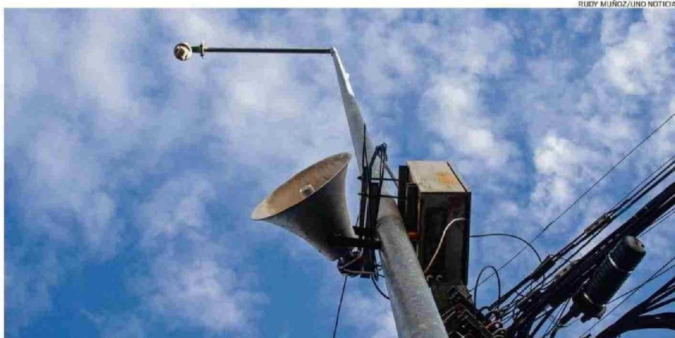
ESTE PARLANTE ESTÁ UBICADO EN CAUQUENES AL LLEGAR A URMENETA.
