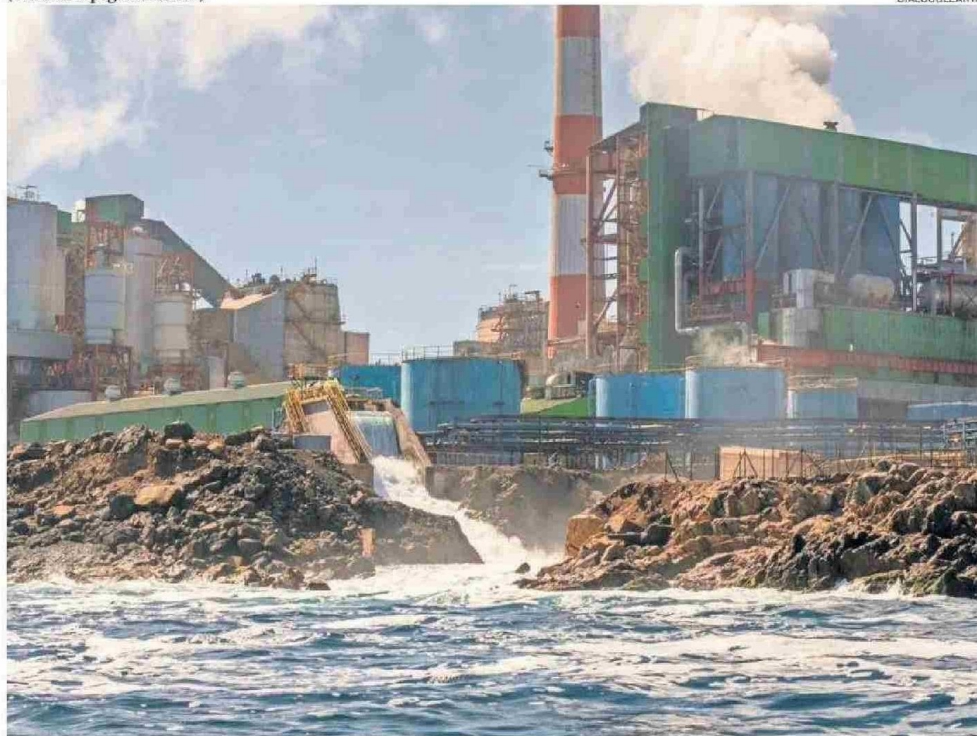
EL AGUA UTILIZADA PARA LA REFRIGERACIÓN POR EL COMPLEJO ENERGÉTICO DE GUACOLDA SE DEVUELVE AL MAR.
