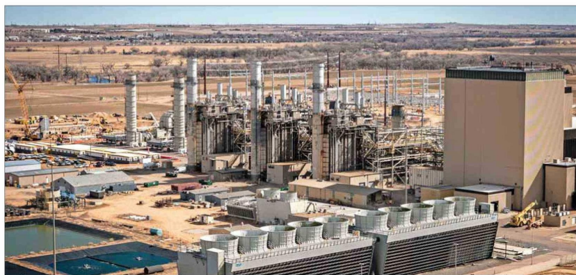
Una central eléctrica de gas en Colorado.
