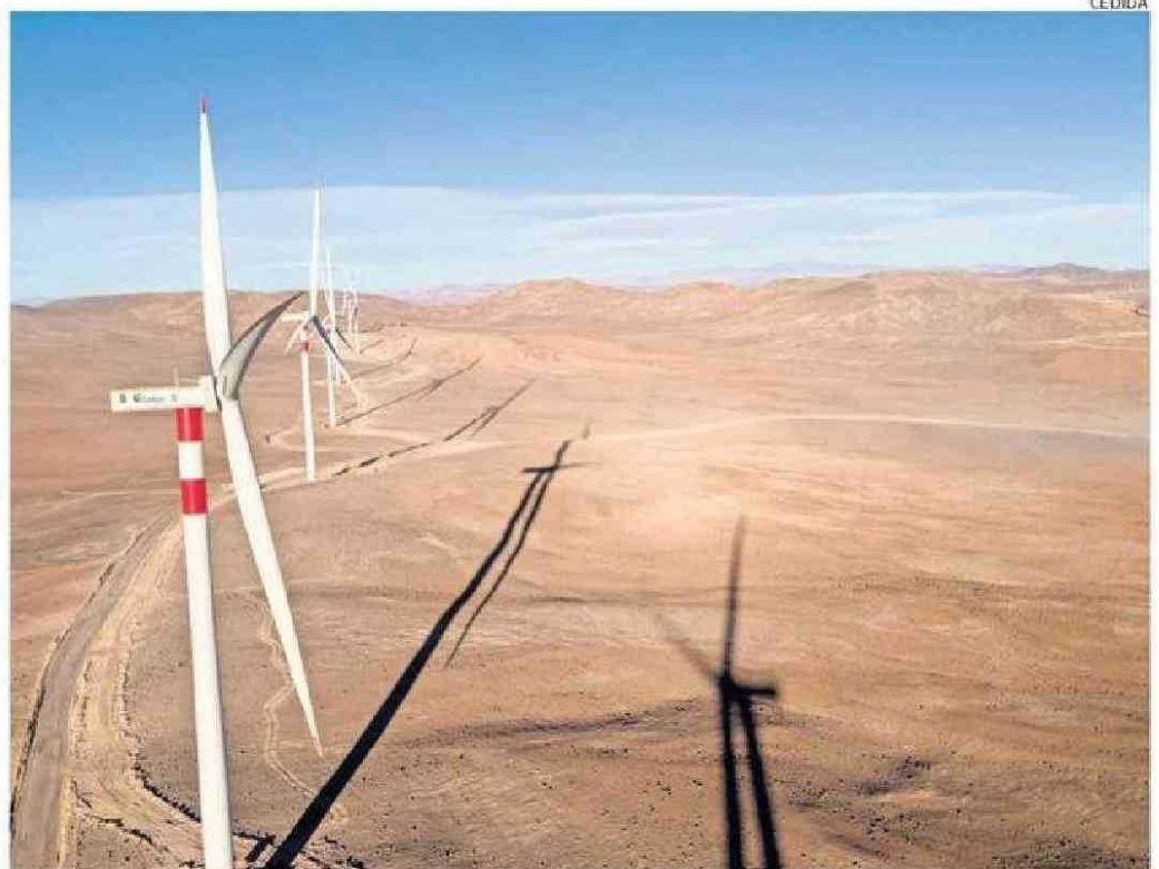
DE APROBARSE SU PROYECTO DE MODIFICACIÓN, LA CENTRAL ALCANZARÍA 996 MW DE POTENCIA INSTALADA.
