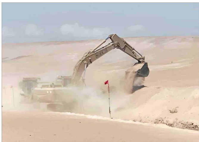
TRABAJO CON MAQUINARIA PESADA. — El Ministerio de Obras Públicas informó que el inicio de los trabajos, junto al paso Chacalluta y el límite internacional con Perú, se concentró entre los hitos 2 y 10.
