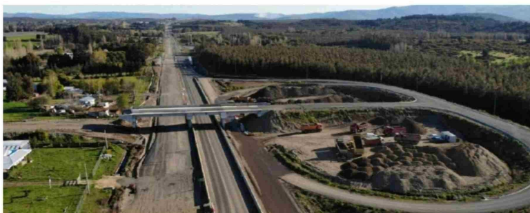
EL TRAMO NACIMIENTO-COIHUE de la nueva Ruta Nahuelbuta preocupa por su potencial impacto vial.
