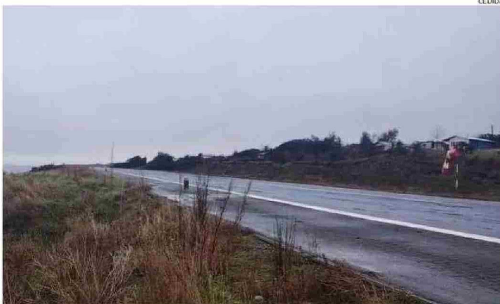
EL AERÓDROMO DE AYACARA ESTÁ PAVIMENTADO Y CON CERCO PERIMETRAL.
