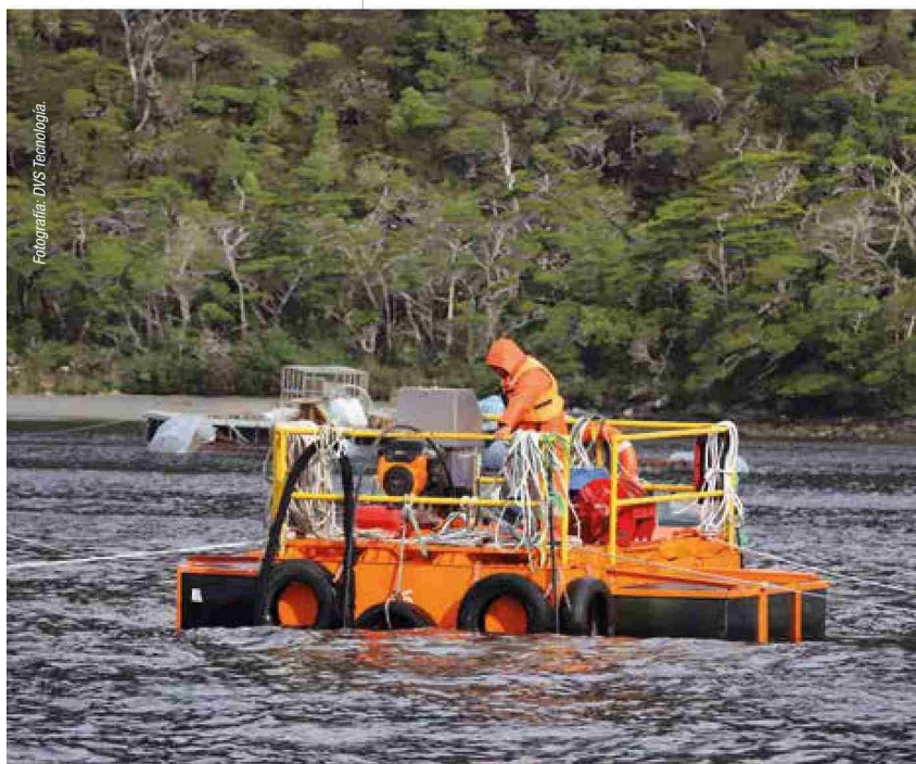
DVS Tecnología en faena con personal operando sobre plataforma.
