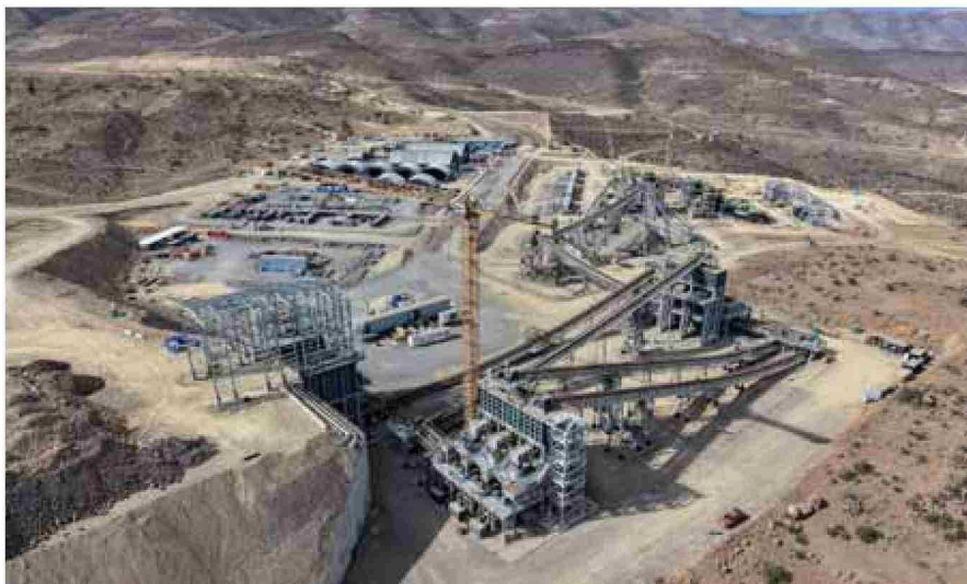
La operación El Espino considera la explotación a rajo abierto, junto con el desarrollo de una planta concentradora para procesar minerales sulfurados.
