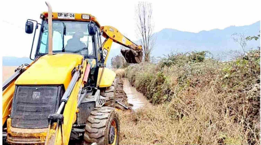
Los trabajos de limpieza de canales se extenderán por siete meses.
