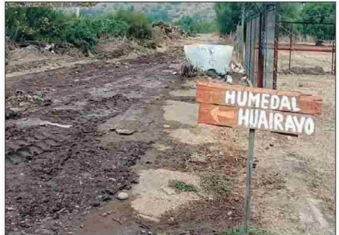
El ingreso de grandes maquinarias y vehículos pesados ha causado daños en el sitio, como muestra la imagen.
