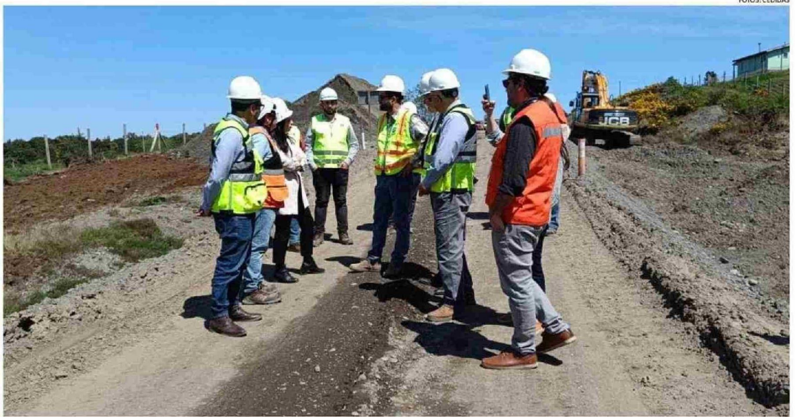
A MEDIADOS DEL AÑO PASADO SE RETOMARON LAS OBRAS DEL BYPASS DE CASTRO LUEGO QUE FUERAN ABANDONADAS POR SEGUNDA VEZ.
