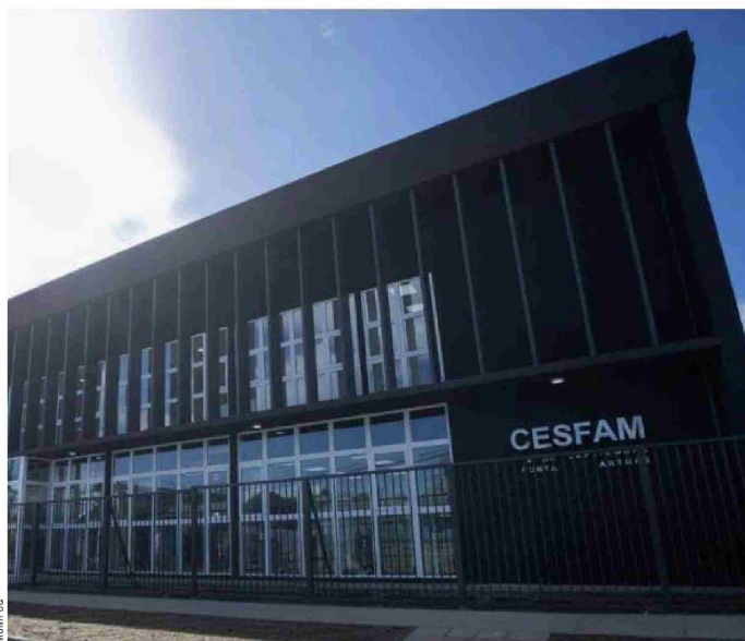
Nuevo Centro de Salud Familiar 18 de Septiembre.
