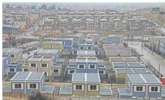
El conjunto habitacional Valle Los Sauces totaliza 500 viviendas construidas con aportes del Minvu, del gobierno regional y de las propias familias.
