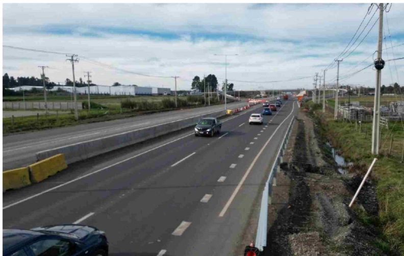
ESTE 1 DE SEPTIEMBRE se realizará la marcha operativa del Tramo B de la Ruta Nahuelbuta, lo que dejará pendiente de ejecución el 5% de las obras, correspondientes al Tramo A.
