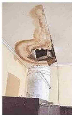
Daño en cielo por filtración en la Escuela Capitán Juan Ladrillero. En la izquierda la imagen de 2023 y a la derecha la correspondiente a 2024.
