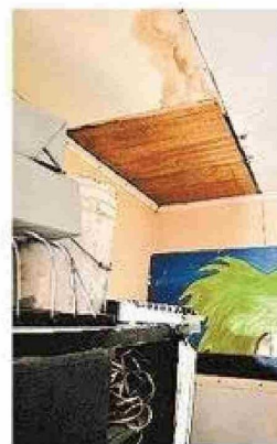
Daño en cielo por filtración en la Escuela Capitán Juan Ladrillero. En la izquierda la imagen de 2023 y a la derecha la correspondiente a 2024.
