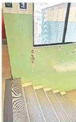
Paredes dañadas por filtración en la Escuela Bernardo O'Higgins. En la izquierda la imagen de 2023 y a la derecha la correspondiente a 2024.
