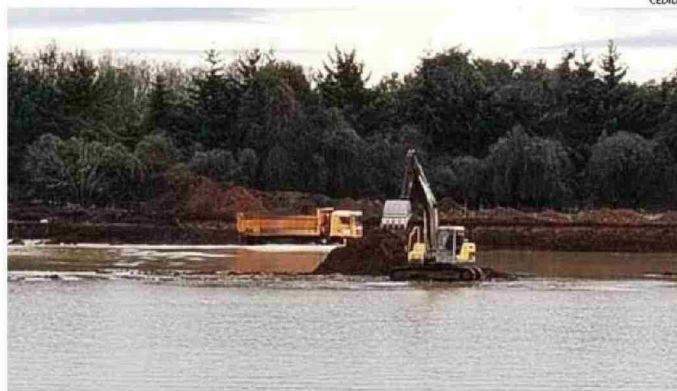
EN LA FAENA HAY MAQUINARIA PESADA PARA EXTRAER GRANDES CANTIDADES DE MATERIAL PÉTRICO DEL RÍO.
