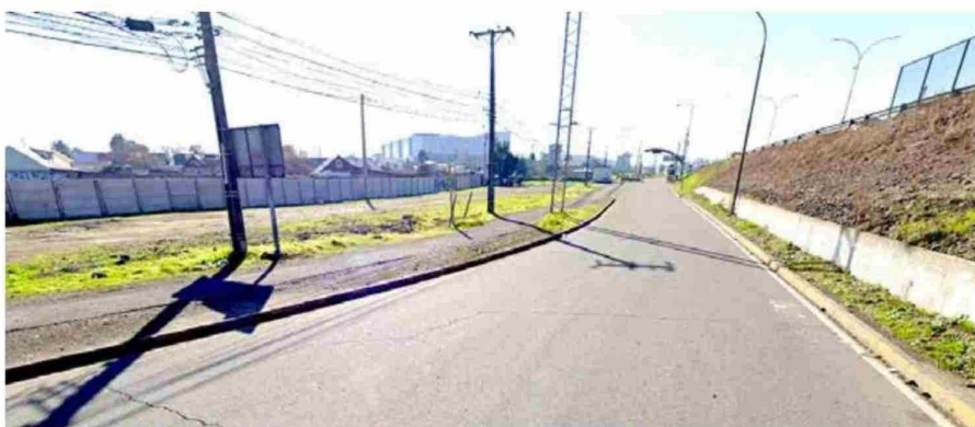
La caletera permitirá descongestionar el tránsito vehicular hacia el nuevo Hospital de Curicó.
