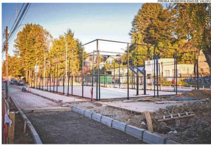
EL PROYECTO INCLUYE JUEGOS, MULTICANCHA, PASARELAS, ILUMINACIÓN Y ARREGLO DE CALLES, ENTRE OTRAS.
