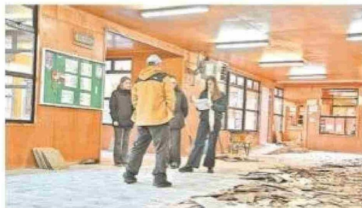
En el Liceo Sara Braun ya se retiraron los antiguos pisos de pasillos y salas, para ser reemplazados por nuevas palmetas de porcelanato.
