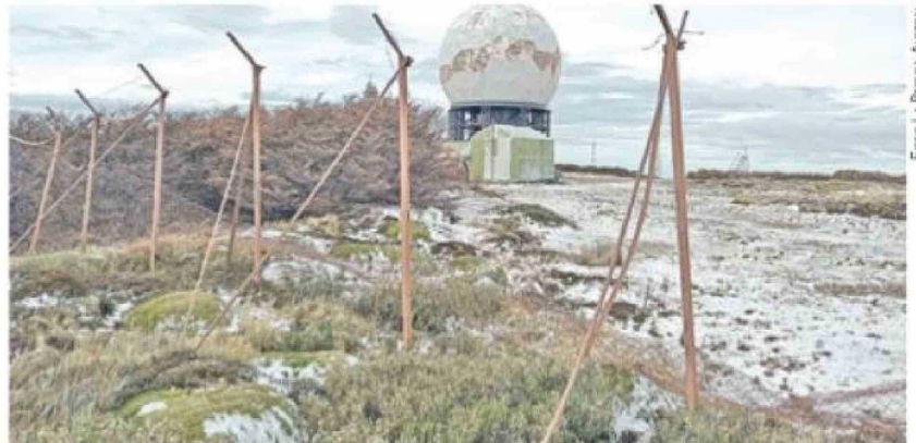
Fotografía del cerco por el lado norte del recinto, con su malla en el suelo.
