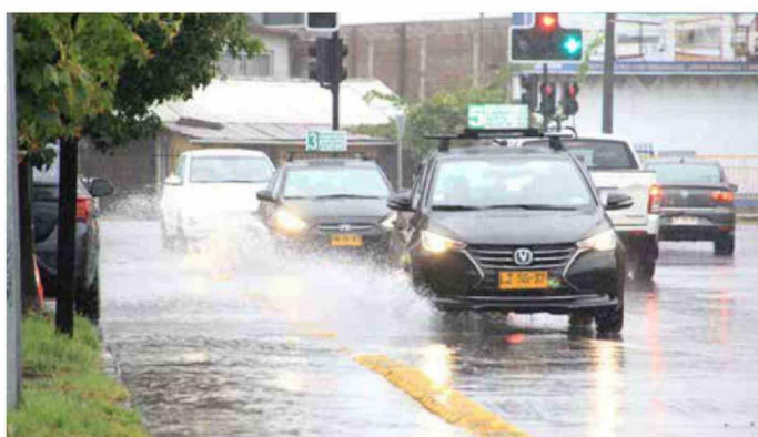
Desde hace un tiempo que se viene pidiendo un mejoramiento del sistema de evacuación de aguas lluvia en el sector Rauquén.
