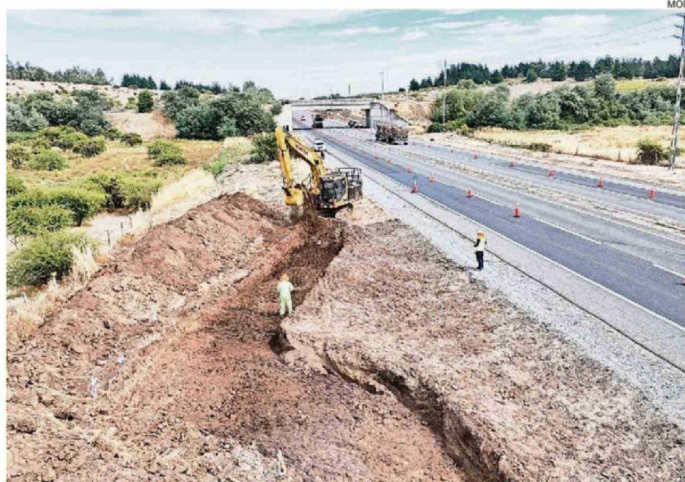
LAS OBRAS DE LA RUTA DEL ITATA COMENZARON Y SE ESPERA UNA MEJORA IMPORTANTE DE LA VÍA,
