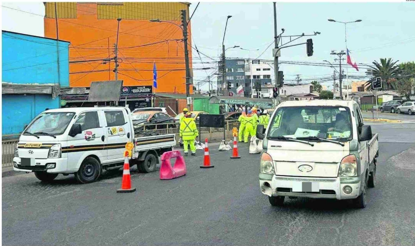
EN SU PRIMER DÍA, LA EMPRESA A CARGO DE LOS TRABAJOS COMENZÓ A DELIMITAR LAS ZONAS QUE SERÁN INTERVENIDAS.
