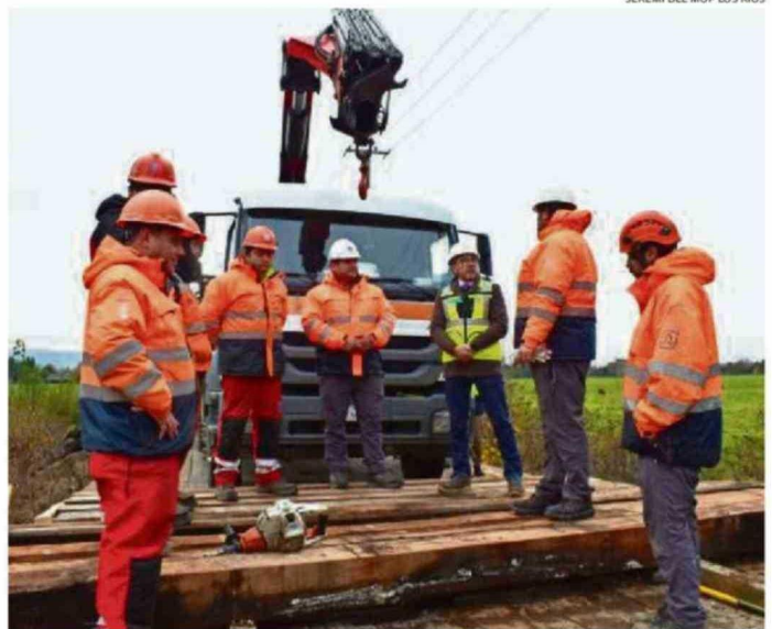
SEREMI ULISES RIVERA REALIZÓ UNA VISITA INSPECTIVA A LAS OBRAS QUE SE REALIZAN EN LOS PUENTES.
