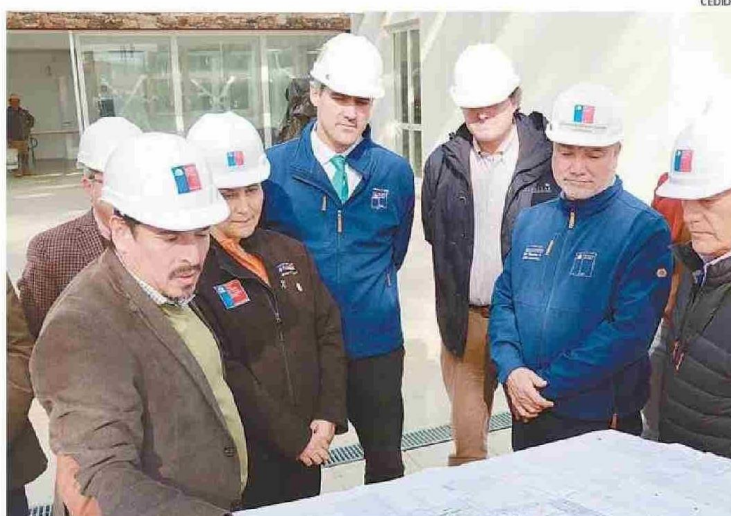
AUTORIDADES REGIONALES Y LOCALES INSPECCIONARON LA OBRA.
