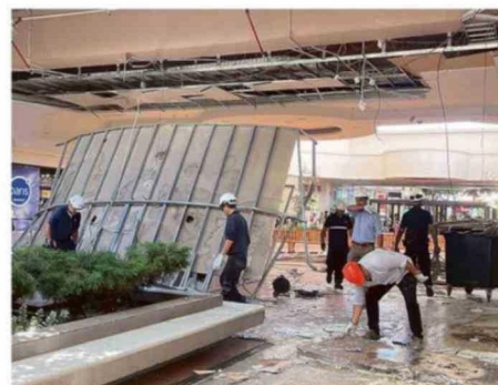
RETIRO DE ESCOMBROS OCASIONADOS POR EL DESPRENDIMIENTO.
