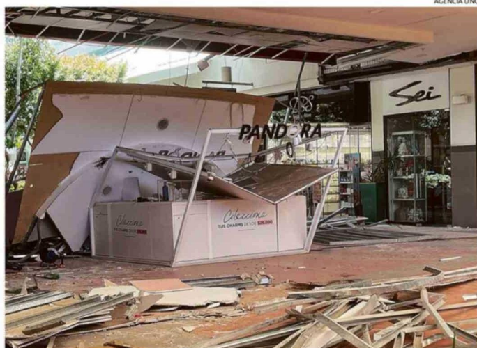
ESTA ES LA ISLA DE LA MARCA PANDORA QUE RESULTÓ CON DAÑOS ESTRUCTURALES TRAS LA CAÍDA DEL CIELO FALSO EN PORTAL BELLOTO DE QUILPUÉ.
