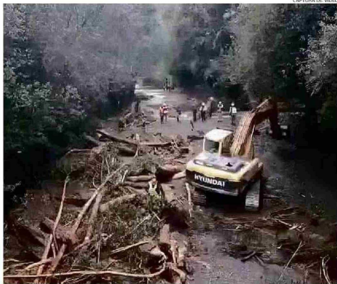
AYER TRABAJABA MAQUINARIA PESADA EN EL LUGAR PARA DESPEJAR LA VÍA COLAPSADA POR TRONCOS.
