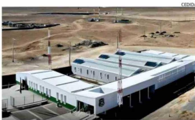
Las obras de la nueva tenencia alcanzan un 98% de avance.
