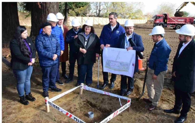
CON LA COLOCACIÓN de la primera piedra, se iniciaron las obras de construcción del Cosam en Los Ángeles.
